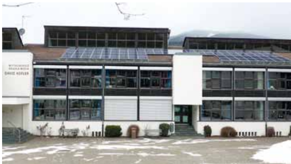
Die Photovoltaikanlage auf dem Dach der Mittelschule muss repariert werden.
