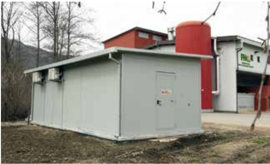
Schritt für Schritt zu schnellerem Internet in Olang: der PoP neben dem Fernheizwerk wurde inzwischen fertiggestellt. In Kürze soll er an das Glasfasernetz angeschlossen werden.
