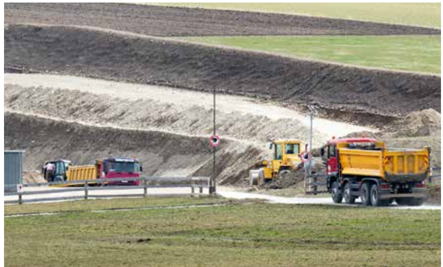
Durch Nutzung der Leerfahrten beim Wiederauffüllen der Schottergrube, können bis zu 400 LKW-Fahrten eingespart werden. Der entsprechende Antrag der Firma Kofler & Rech wurde vom Gemeinderat genehmigt.
