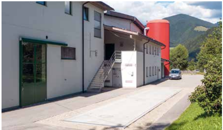
Bis jetzt wurde die angekaufte Biomasse immer in Schüttraummeter verrechnet. Mit der Errichtung der Waage wird künftig auf die Atro-tonne als Maßeinheit umgestellt. Die Atro-tonne ist die Maßeinheit für die Masse einer Tonne absolut trockenen Holzes.
