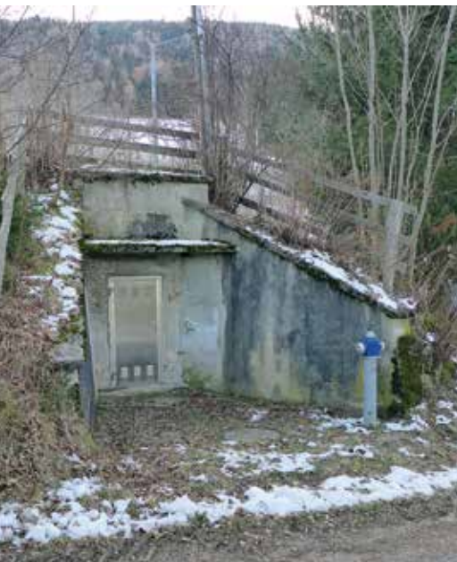
Anstelle des sanierungsbedürftigen Trinkwasserspeichers Urthal wird ein neuer Speicher mit einem Fassungsvermögen von 350 Kubikmeter errichtet.
