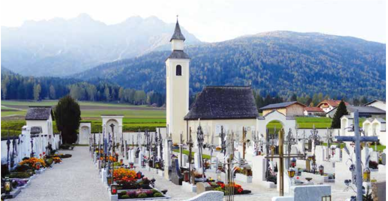
Die Mauern am Oberolanger Friedhof müssen saniert werden.
