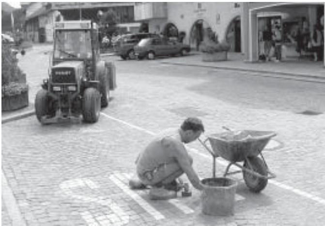
Ausbesserungsarbeiten am lädierten Straßenpflaster vor dem Gemeindehaus in Mitterrolang (Foto: „sq“/rb)
