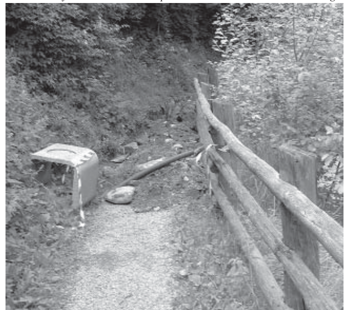
Das Aufstellen der neuen Lampen unter der Wieser Brücke ist im Gange.
