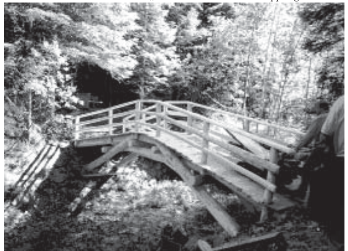
Die bereits errichtete „Leonardobrücke“ am Kneippweg in Taisten
