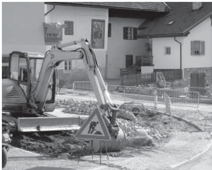
Brunnenplatz in Oberolang: Seit es eine endgültige Einigung gibt, sind die Arbeiten rasch angegangen worden. (Fotos: "sq"/rb)
