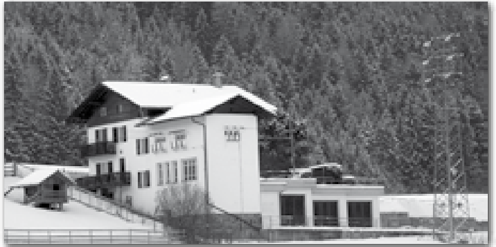
) Eine flächendeckende Versorgung der Dörfer und Bewohner mit Strom muss das Ziel sein (Bild: Elektrozentrale in Niederolang - Foto: „sq“/rb)
