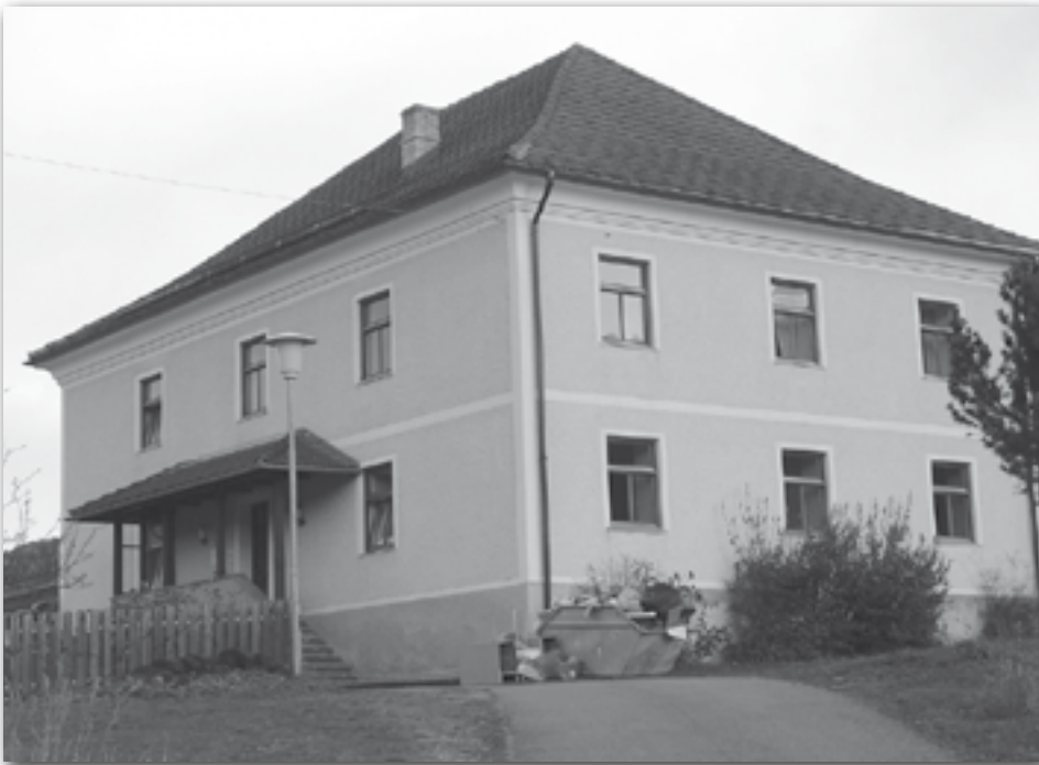
) Für die Sanierung des Oberolanger Widums wurden weitere 25.000 Euro vorgesehen. (Foto: „SQ“/rb)
