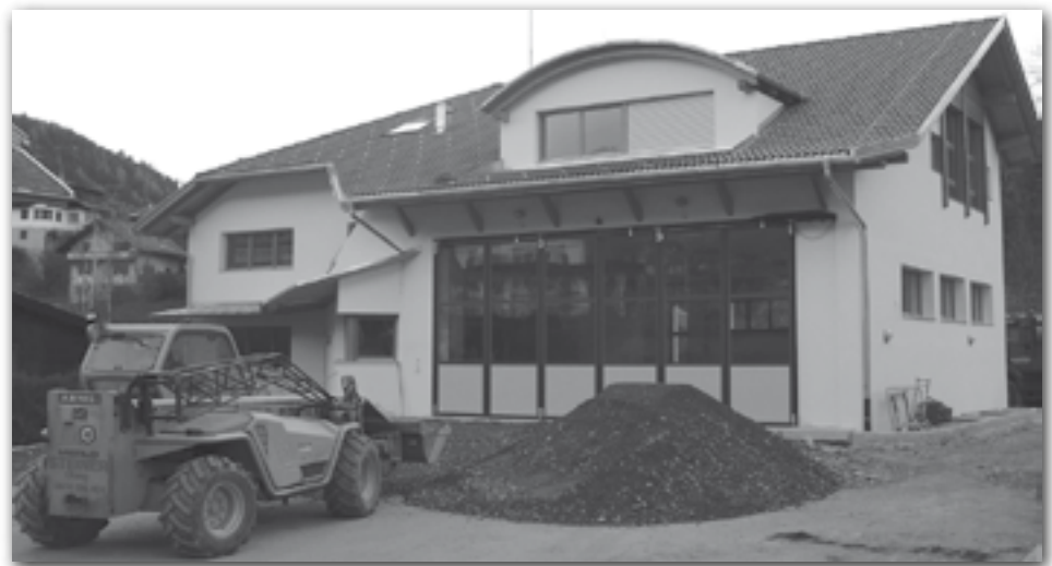
) Das neue Feuerwehrhaus: Langsam nimmt es Formen an. (Foto: Repro „SQ“)
