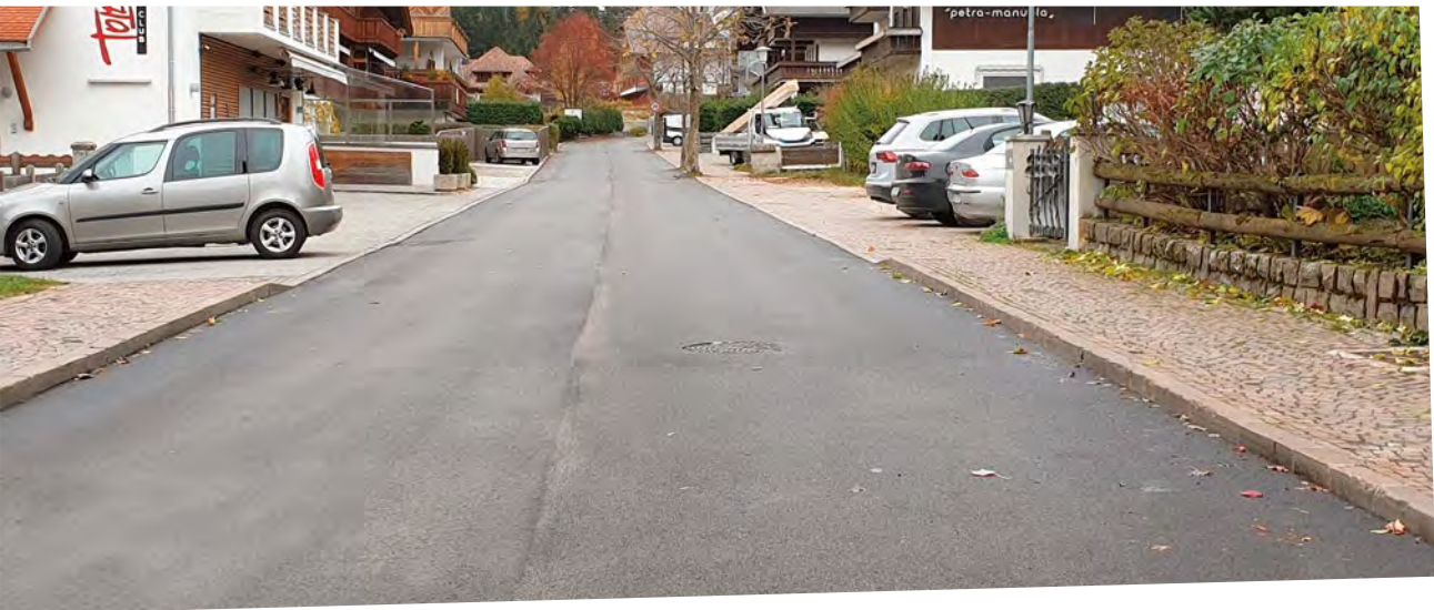
Der Ägidiusweg in Mitterolang wurde neu hergerichtet.
