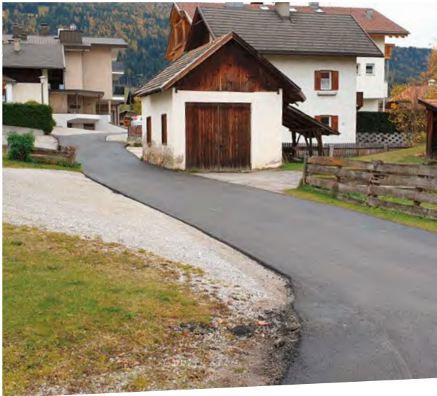
Die Sanierung des Palmpeintenweges in Mitterolang.
