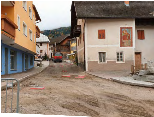
Die Kirchgasse in Oberolang wurde ebenfalls saniert.
